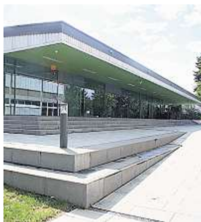
Die neue Turnhalle des AMG
