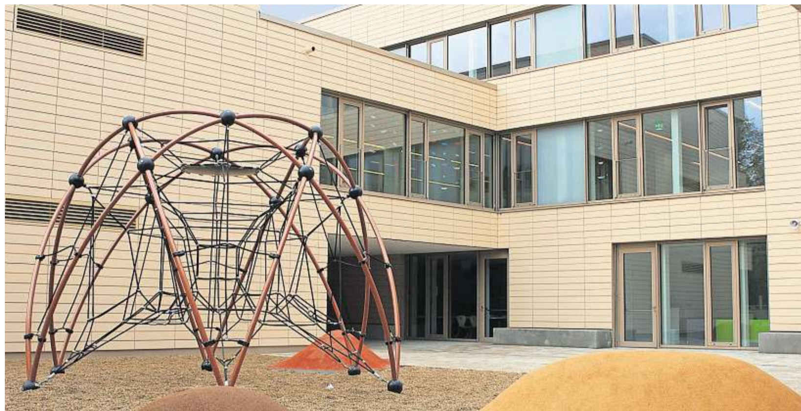
Die Außenfassade der Grundschule am Napoleonstein präsentiert sich in warmen und hellen Erdtönen.
