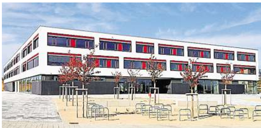
Die Ostfassade des Lappersdorfer Gymnasiums
