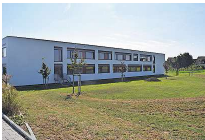
Auf der Nordseite des Lappersdorfer Gymnasiums beginnen die Arbeiten.
