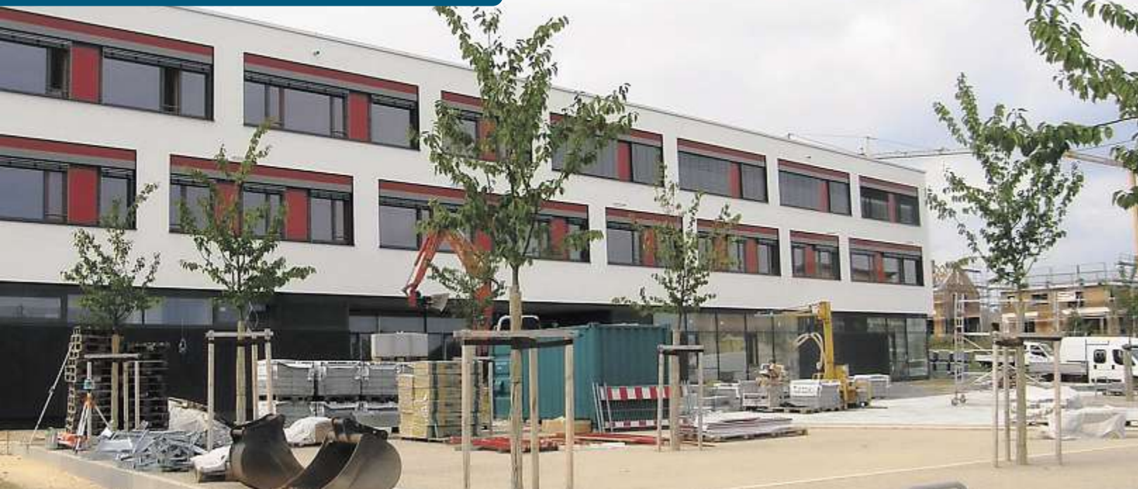
Während der Ferienzeit wurde am Neubau noch emsig bebaut: Insgesamt 22 Millionen Euro investierten der Landkreis Regensburg und der Freistaat in den Neubau des Gymnasiums Lappersdorf. Foto: Geipel
