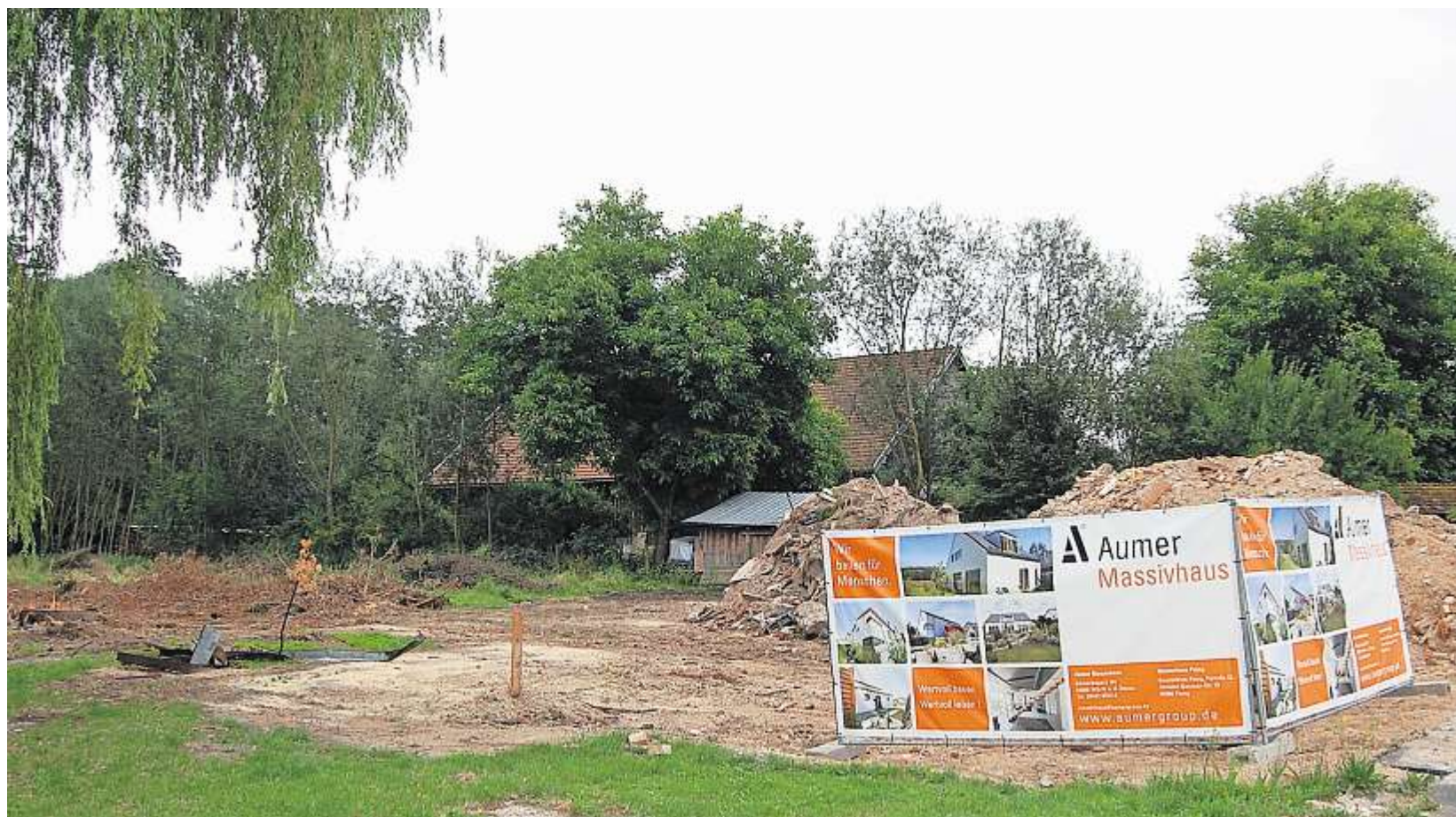
An dieser Stelle will der Bauunternehmer Ernst Aumer ein Neunfamilienhaus errichten.
