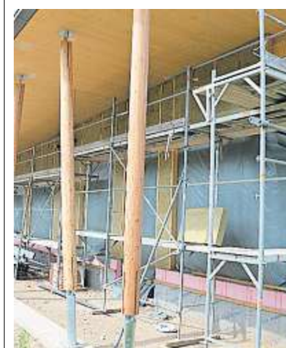
Der Neubau des Kinderhauses schreitet zügig voran. Foto: Biederer
