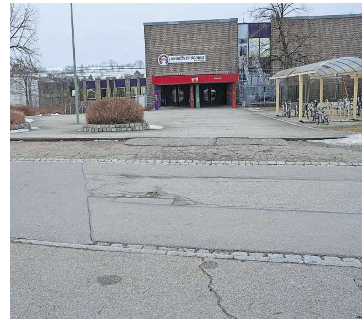
Die Sanierung der Angrüner-Mittelschule ist Teil des Gesamtkonzepts.
